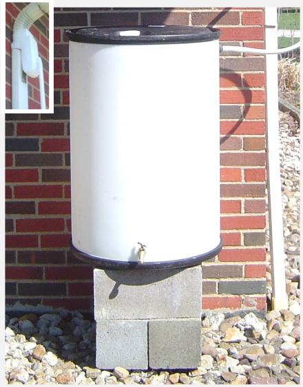
Rain Barrel - 55 gallons
